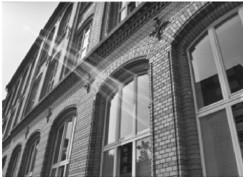
Institutsgebäude in Mannheim, R5, 6-13
